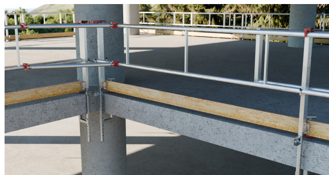
Klemme fixiert an die Betondecke
