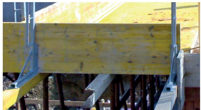
Il **supporto d'armatura-squadretta** è un attrezzo moderno che consente di eseguire lavori di riempimento di solai o scale in modo veloce, comodo e sicuro. La squadretta è dotata di fori per il fissaggio alle tavole, quindi sempre riutilizzabile ed evita sprechi di legname. La squadretta è progettata per gettare fino a 30 cm di altezza (interasse vedi tabella). Compatibile, per la messa in sicurezza del posto di lavoro, con il parapetto universale (pag. 28).
