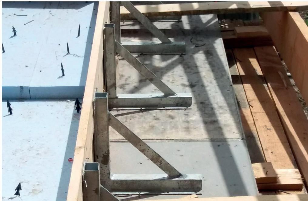
Die **Schalstütze** ist ein modernes Werkzeug, mit dem Sie verschiedene Auffüllarbeiten an Decken oder Treppen schnell, bequem und sicher durchführen können. Die Halterung ist mit Löchern zur Befestigung an den Holzbrettern ausgestattet, so dass sie immer wieder verwendbar ist und Holzverschwendung vermeidet. Die Stütze ist für eine Deckenhöhe von bis zu 30 cm ausgelegt (Achsenabstand siehe Tabelle). Für die Sicherheit am Arbeitsplatz kompatibel mit dem Universalen Seitenschutz (Seite 28).
