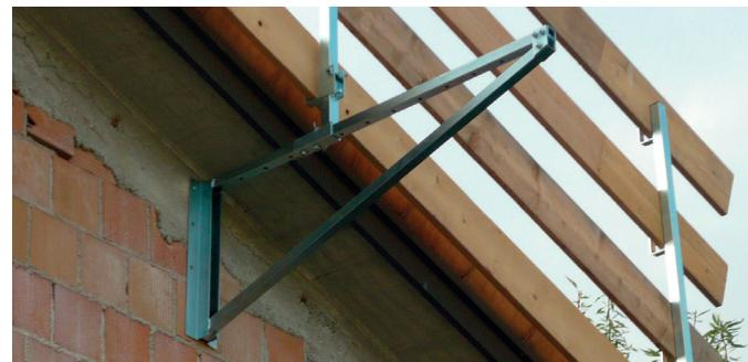
Die **Seitenschutzkonsole** 125 ist ein System zur Sicherung von Gebäuden gegen das Herabfallen von Personen und/oder Material aus der Höhe. Sie ermöglicht es, eine maximal 125 cm breite Gehfläche um das Gebäude herum zu schaffen, um Wartungsarbeiten durchzuführen oder die Dachrinne auszutauschen.
