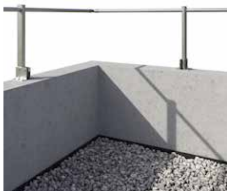
Ausführung 1 - mit Brüstung \geq 60 cm
