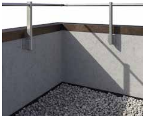
Ausführung 1 - mit Brüstung \geq 60 cm
