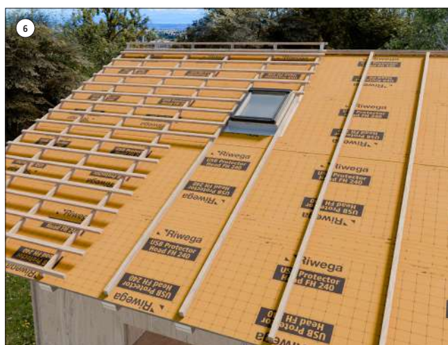
6 Por último, proceder a la colocación de los contrarrastreles restantes y los rastreles para tejas
