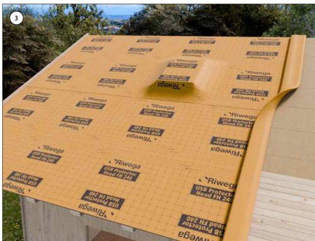
3 Después de fijar el contrarrastrel al borde, desenrollar la membrana procediendo horizontalmente
