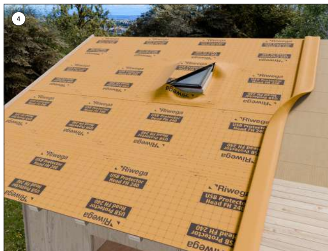
4 Cortar la membrana y sellarla alrededor de los cuerpos que emergen mediante los accesorios
