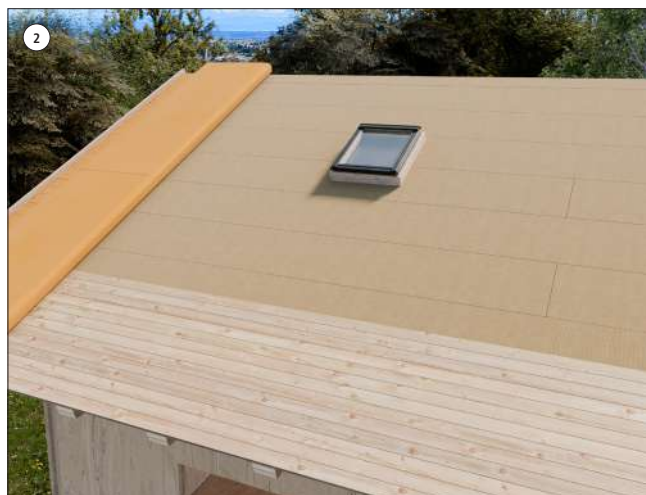
2 Desenrollar la membrana comenzando en sentido vertical y fijar el primer contrarrastrel al borde del faldón
