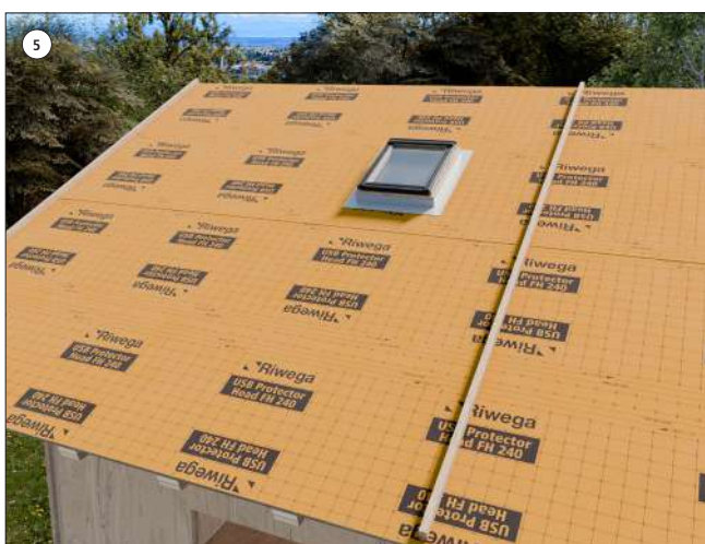
5 Una vez extendida la membrana sin que presente pliegues, fijarla con un segundo contrarrastrel
